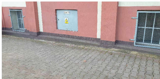
Fot. 2. Brak spadków, zagłębienie, w którym zalega woda.
