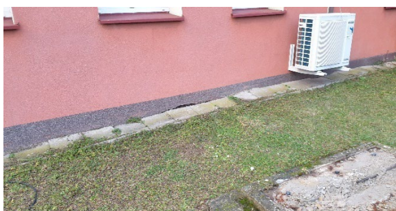
Fot. 1. Zapadnięte płyty opaski.
